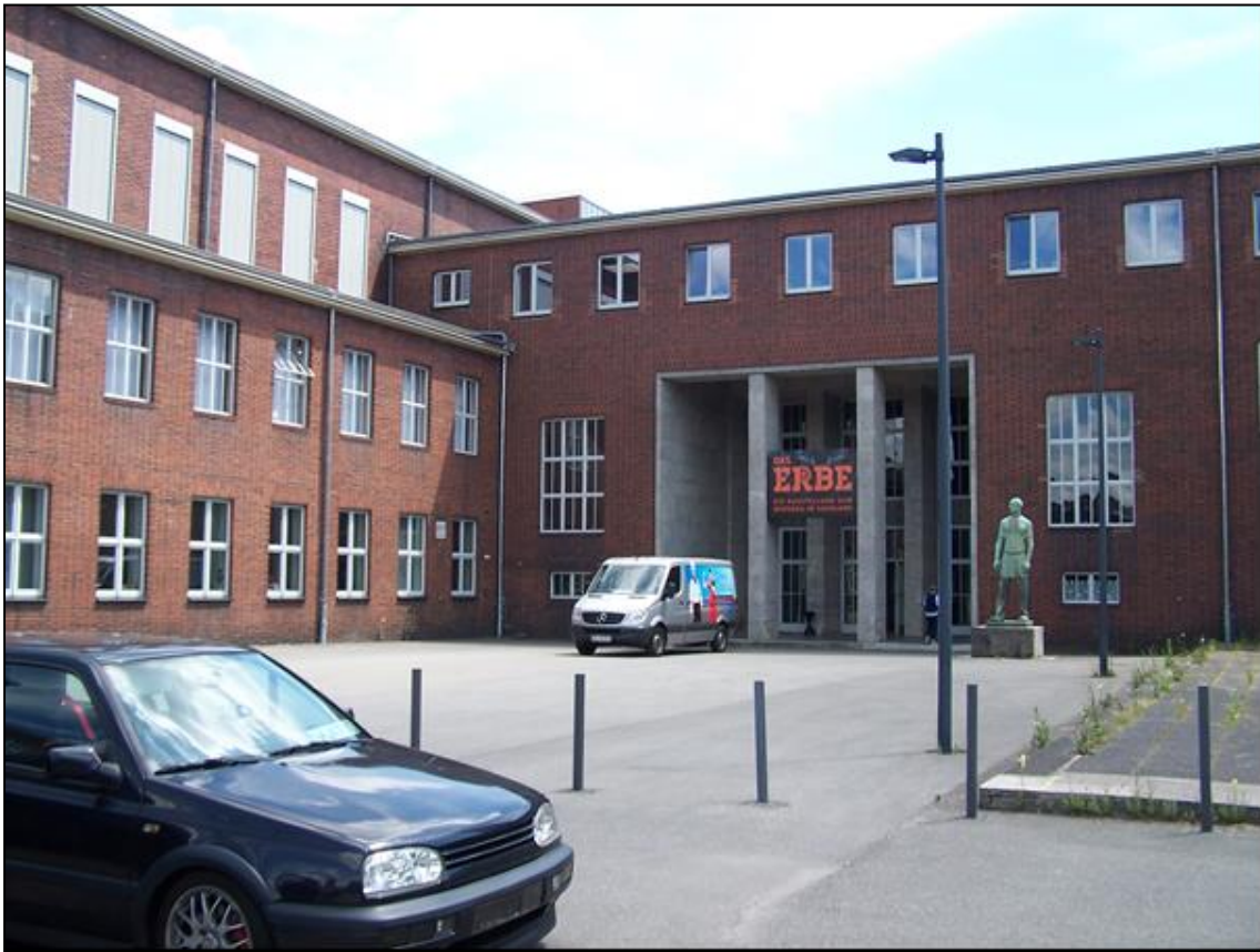
Bild 7: Liegenschaft Am Bergwerk Reden 10 – 11
