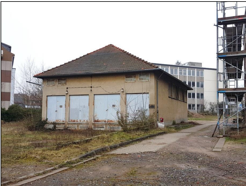
Bild 18: Bereich des ehemaligen Trafohauses
