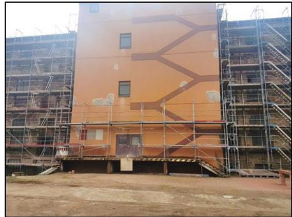
Bild 4: Ansicht Treppenhaus Nordfassade
