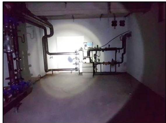
Bild 6: Hausanschluss Fernwärme
