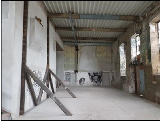
Bild 7: Foyer im Eingangsbereich
