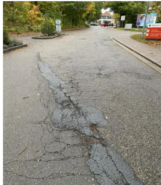
Löcher in der Deckschicht
