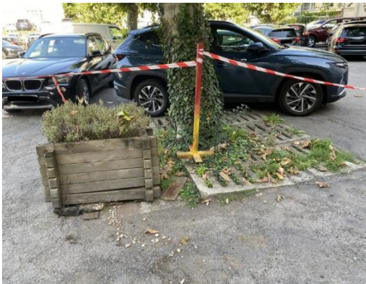
Baumscheibe mit Wurzelschutz
