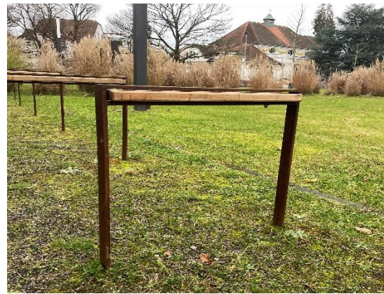
Fahrradbügel nachher mit Distanzhölzern
