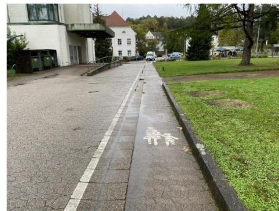
Fehlender baulicher Gehweg
