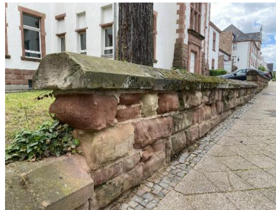
Verwitterte Sandsteinmauer
