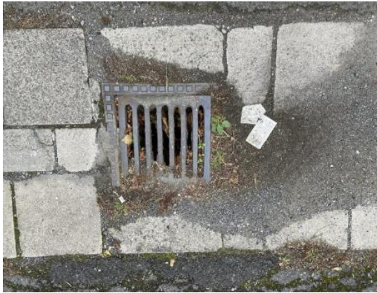
Versandeter Einlaufschacht
